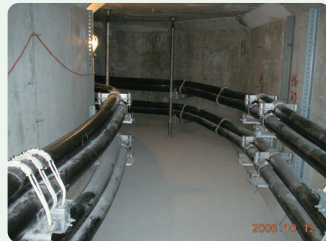
▼ 台電週美~北資輸電線路工程
