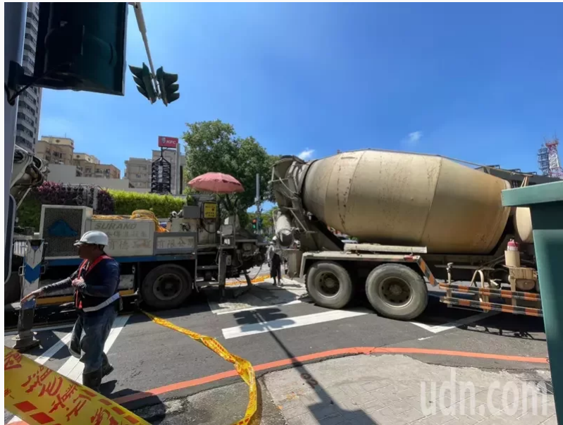
建商已進行灌漿回填地基作業，預計3天內完成假修復。記者黃羿馨／攝影
