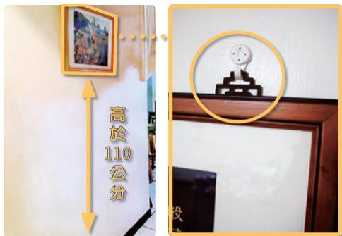
▲ 壁掛物掛於 110 公分以上，且確認其穩固
